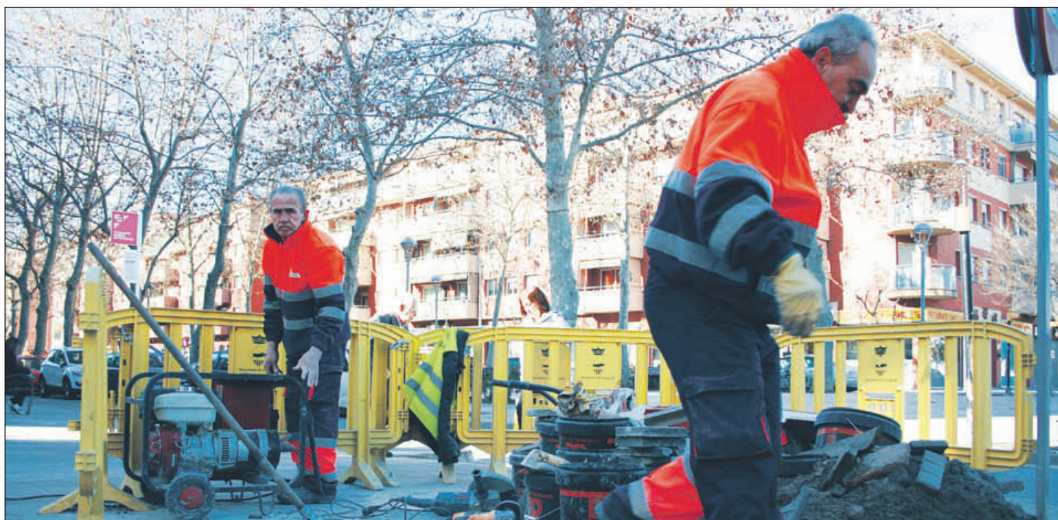
Dos operaris de la brigada municipal d'obres fan tasques de manteniment urbà a l'avinguda de l'Onze de Setembre.
