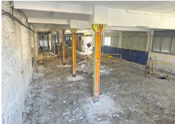
Espai en el qual s'està treballant en la primera fase de les obres.
