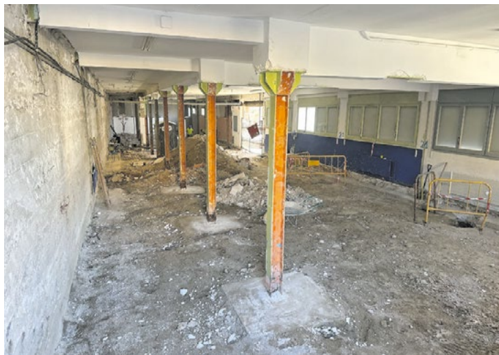
Espacio en el que se está trabajando en la primera fase de las obras.
