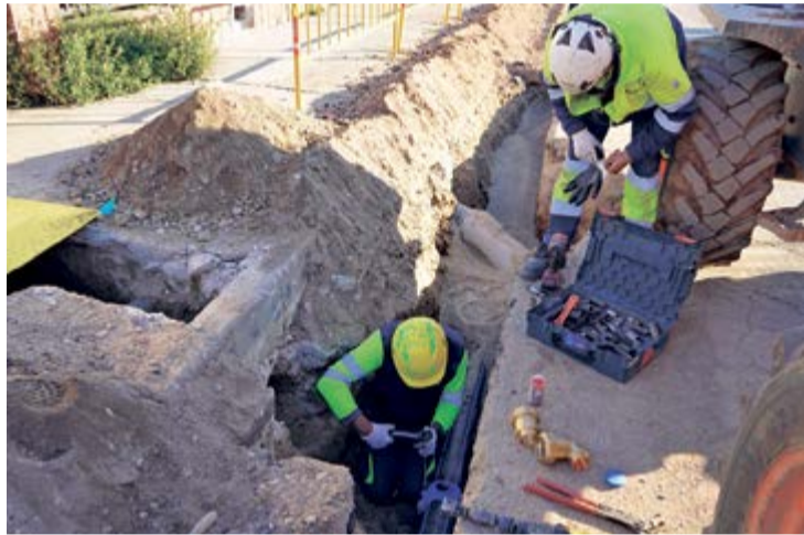
La actuación se ha iniciado en la calle Montseny.
