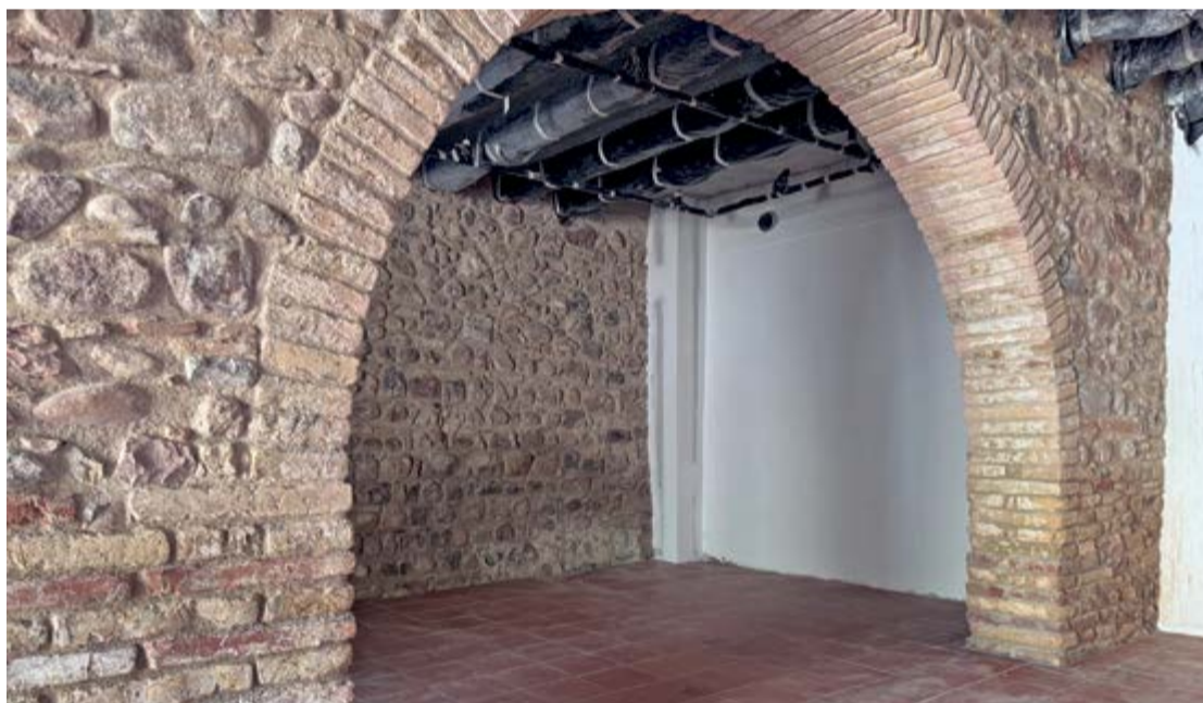
Las obras de reforma de Can Baqué están en su recta final.
