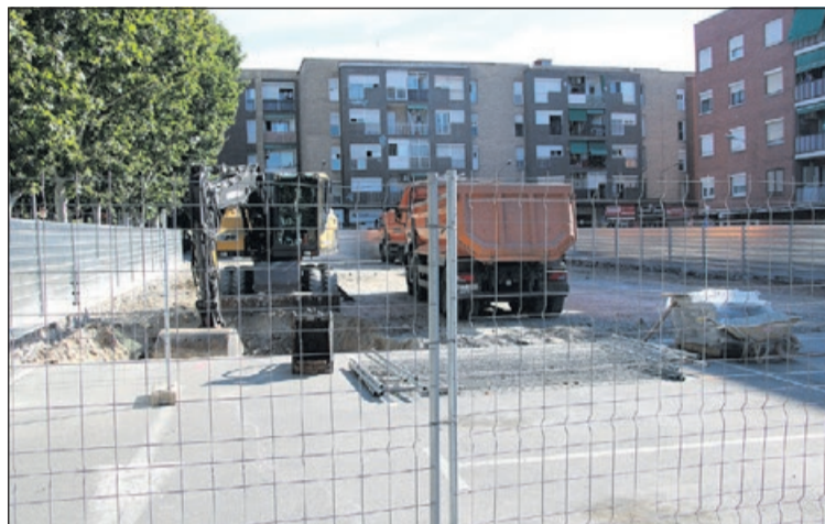
Obres del nou CAP de la Llagosta.
