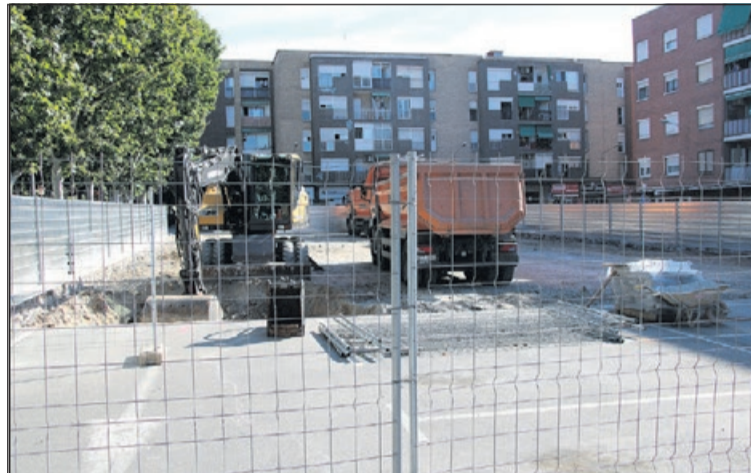
Obras del nuevo CAP de La Llagosta.
