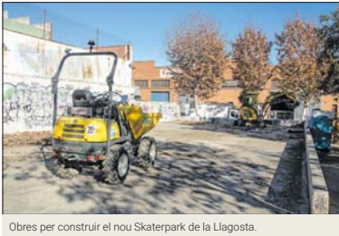
Obres per construir el nou Skatepark de la Llagosta.
