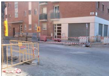
Obras para instalar un paso de peatones elevado.
