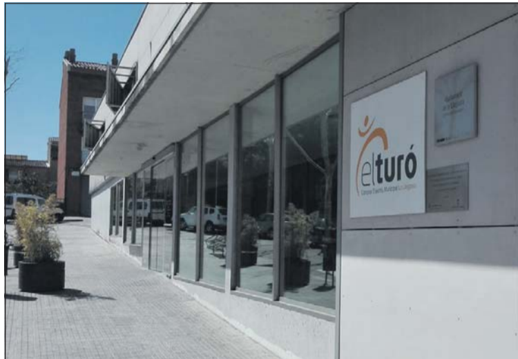
Entrada del Complejo Deportivo Municipal El Turó.
