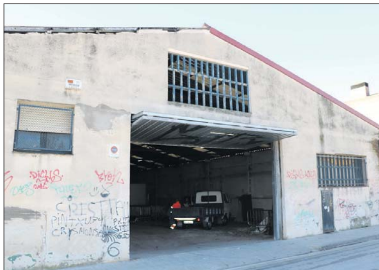
La nau municipal del carrer de Sant Llorenç.
